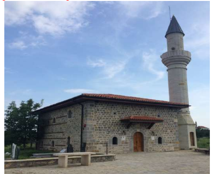
Caminin onarıldıktan sonraki şekli
